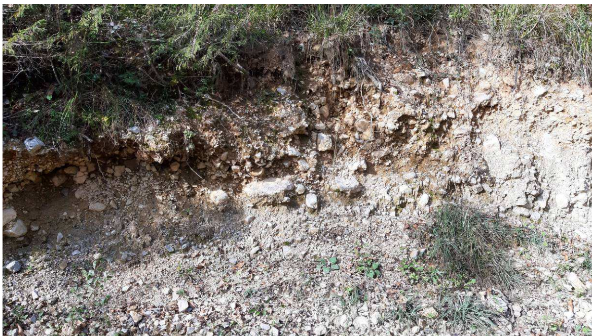
Immagine n. 8: scarpata stradale in lenta ma progressiva erosione (oggetto d'intervento n. 2), costituita da detriti di falda da sciolti a variamente cementati
